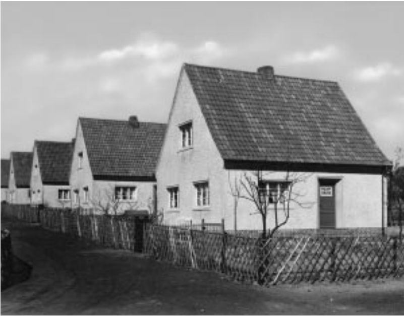
Zigarrenarbeitersiedlung Südlengern, Bf. 1927
