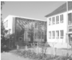
Anbau an der Grundschule Ubbedissen
